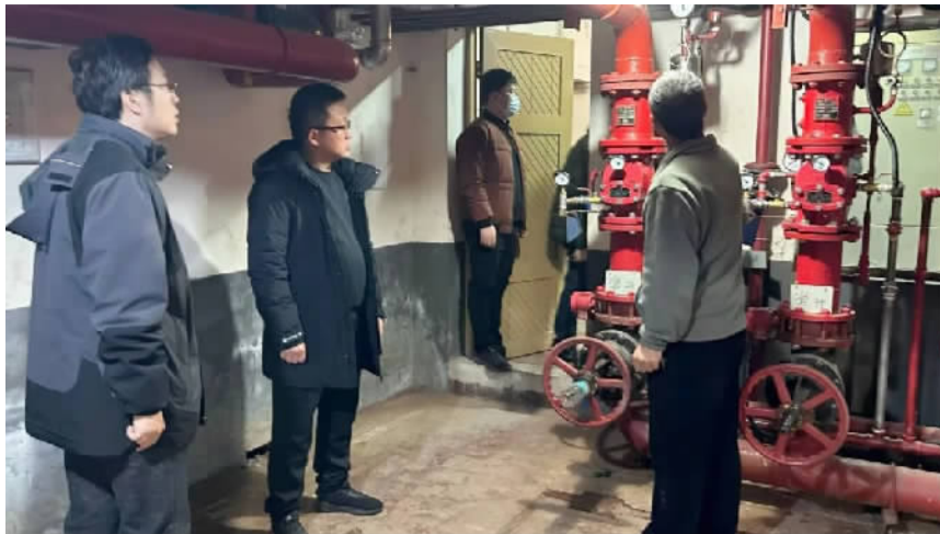
安全检查现场
