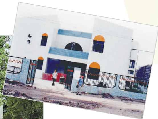
▲建造中的凉城第四幼儿园（1994年摄） ◀如今的凉城第四幼儿园（摄于锦苑小区）
