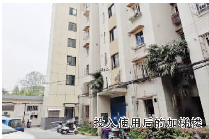
投入使用后的加梯楼
