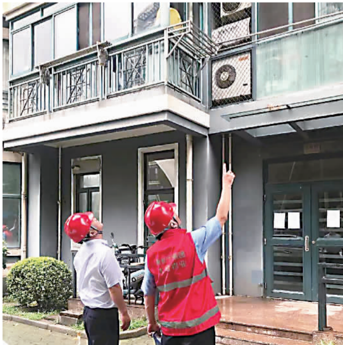
排除高空坠物风险隐患
