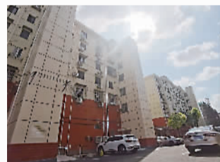
三台加装电梯全部竣工并投入使用
