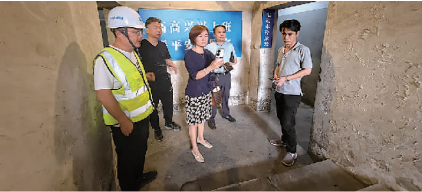
人大代表实地走访施工改造现场
